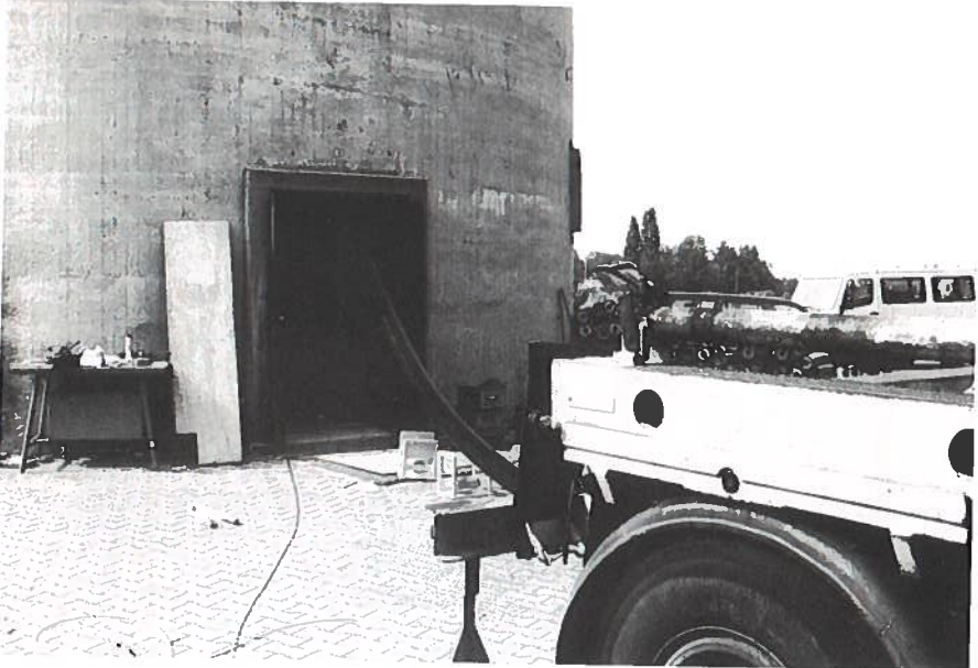
De kabel wordt de toren ingetrokken
